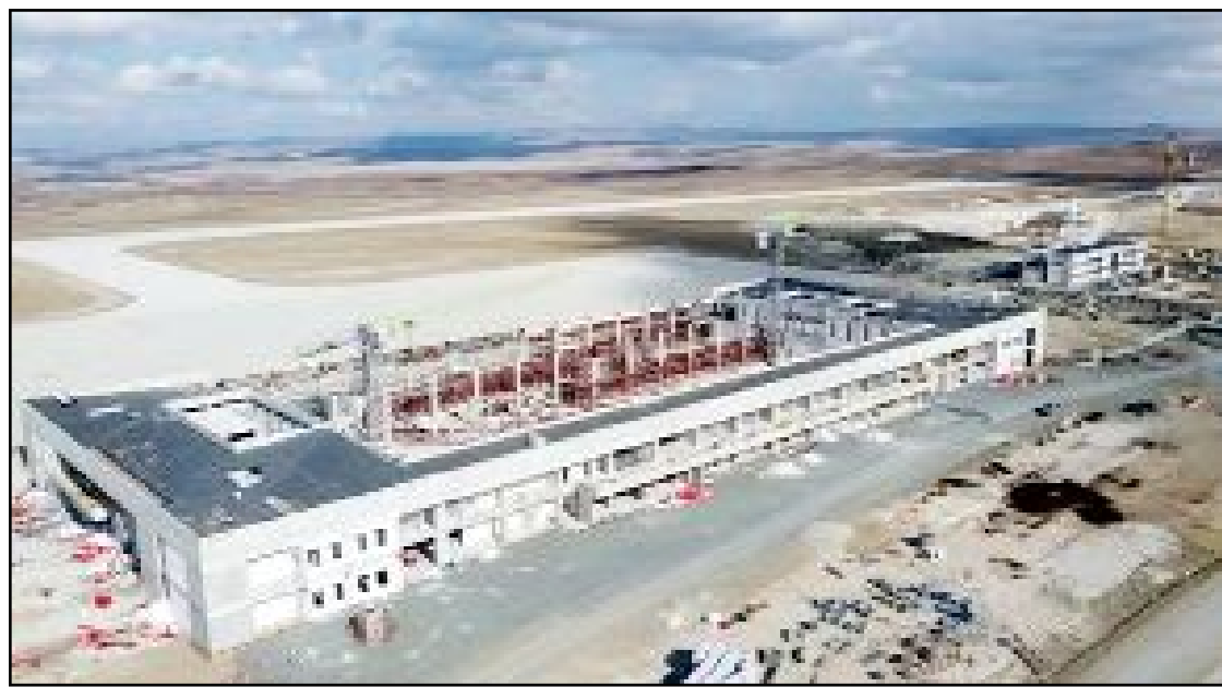
Yozgat Havalimanı terminali tamamlanmak üzere...
