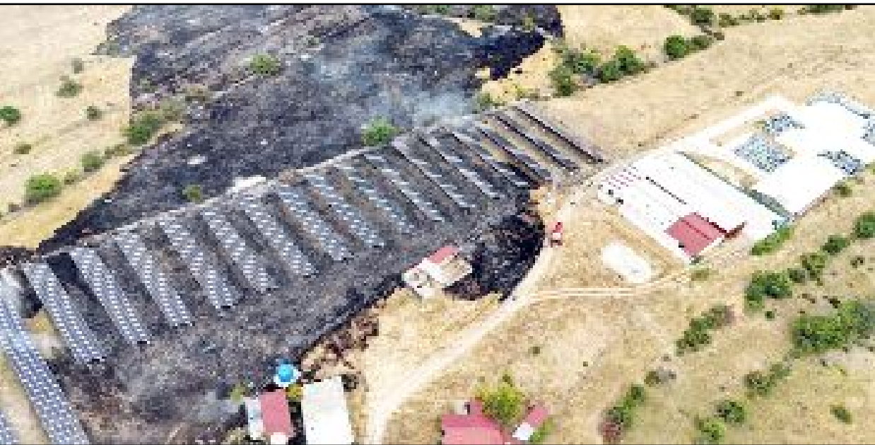
Kısa sürede bölgede bulunan bir GES santraline sıçrayan yangında 4 panel zarar gördü.
