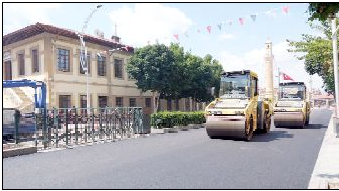
Altyapı çalışmalarının tamamlanmasının ardından asfalt serimine başlayan Çorum Belediyesi, 1.700 metrelik güzergâhta yaklaşık 9 bin ton sıcak asfalt kullanacak.
