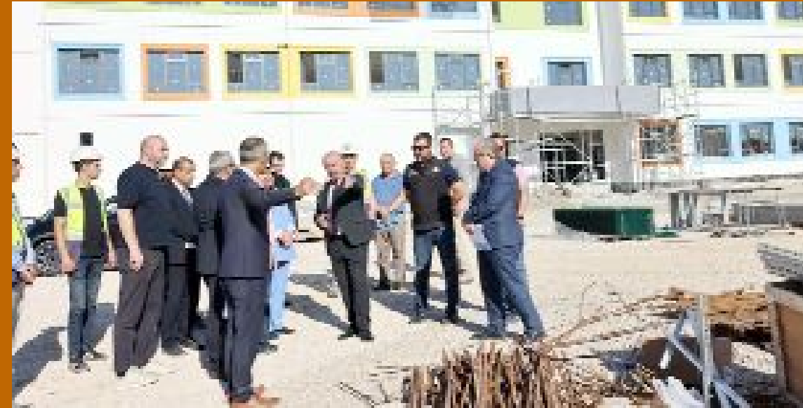
Vali Ali Çalgan inşaatı devam eden eğitim kurumlarının son durumları hakkında bilgi aldı.
