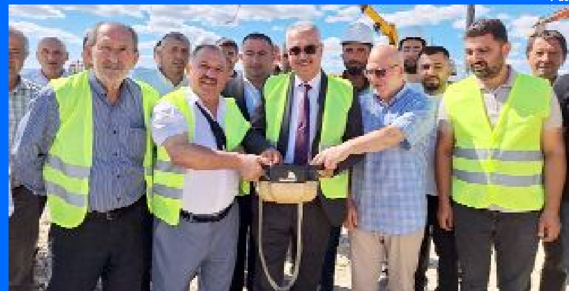
S.S. Zanaatkarlar Küçük Sanayi Sitesi Yapı Kooperatifi içinde yer alan Keresteciler bölümünün idari binaları için temel atıldı. Törene Çorum Milletvekili Yusuf Ahlatcı da katıldı.
