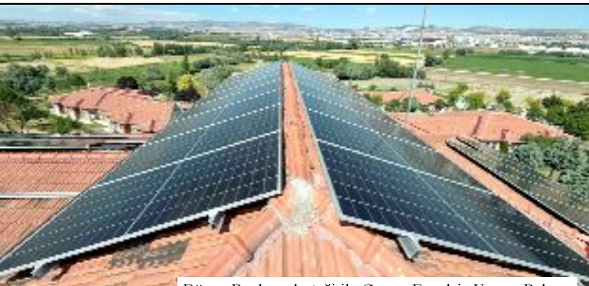
Dünya Bankası desteği ile Çorum Engelsiz Yaşam Bakım, Rehabilitasyon ve Aile Danışma Merkezi Müdürlüğü'nün çatısında Güneş Enerji Santrali (GES) kuruldu.
