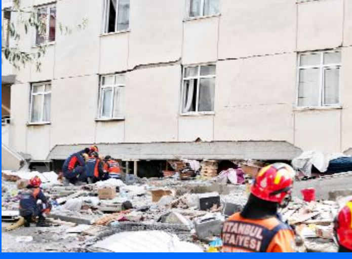
İstanbul Maltepe'de çöken binada 5 kişi hayatını kaybetti.
